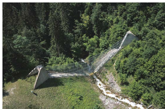
Barrière côté aval (Image: [F]).
