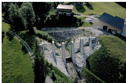
Barrière, côté aval (Image: [F]).
