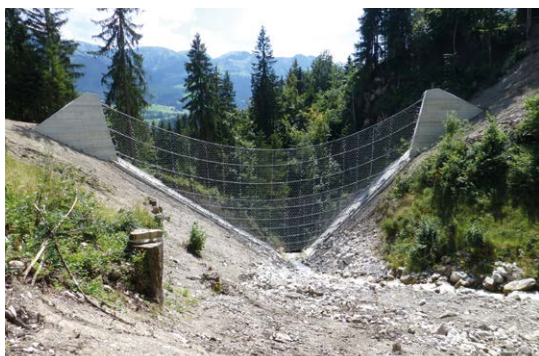
Barrière côté amont (Image: [F]).
