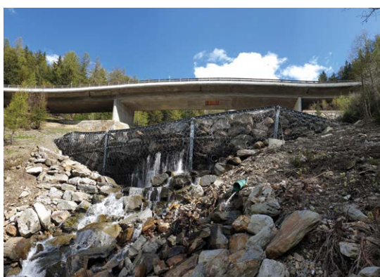
Barrière UX-180-H6 pré-remplie, vue d'aval (Image: [G]).
