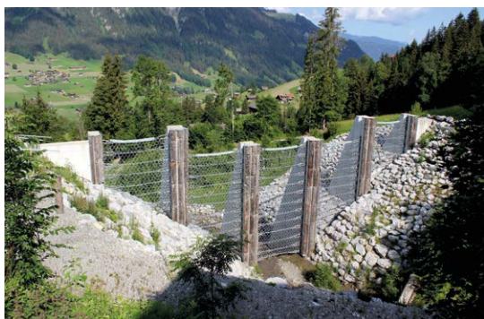
Barrière, côté amont (Image: [F]).
