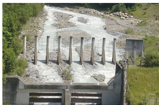
Barrière, côté aval (Image: [F]).
