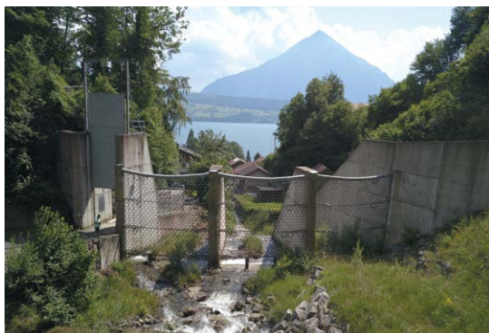
Barrière, côté amont (Image: [F]).
