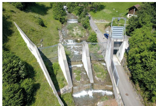
Barrière, côté aval (Image: [F]).
