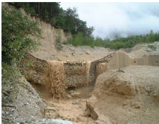
Barrière VX remplie, tronçon d'aménagement 1 (Image: [G]).
