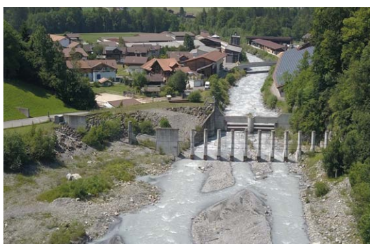
Barrière, côté amont (Image: [F]).
