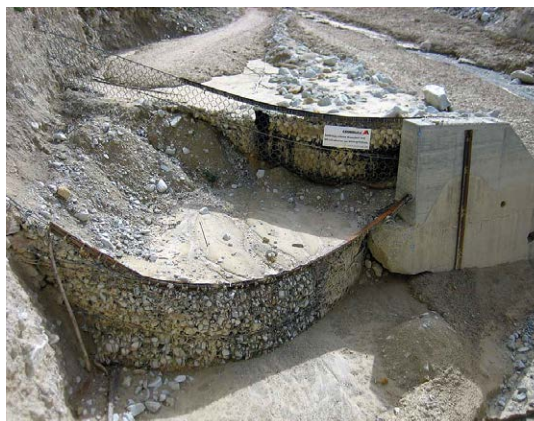
Restauration de l'aile du mur latéral et installation d'une deuxième barrière VX partiellement remplie (Image: [A]).
